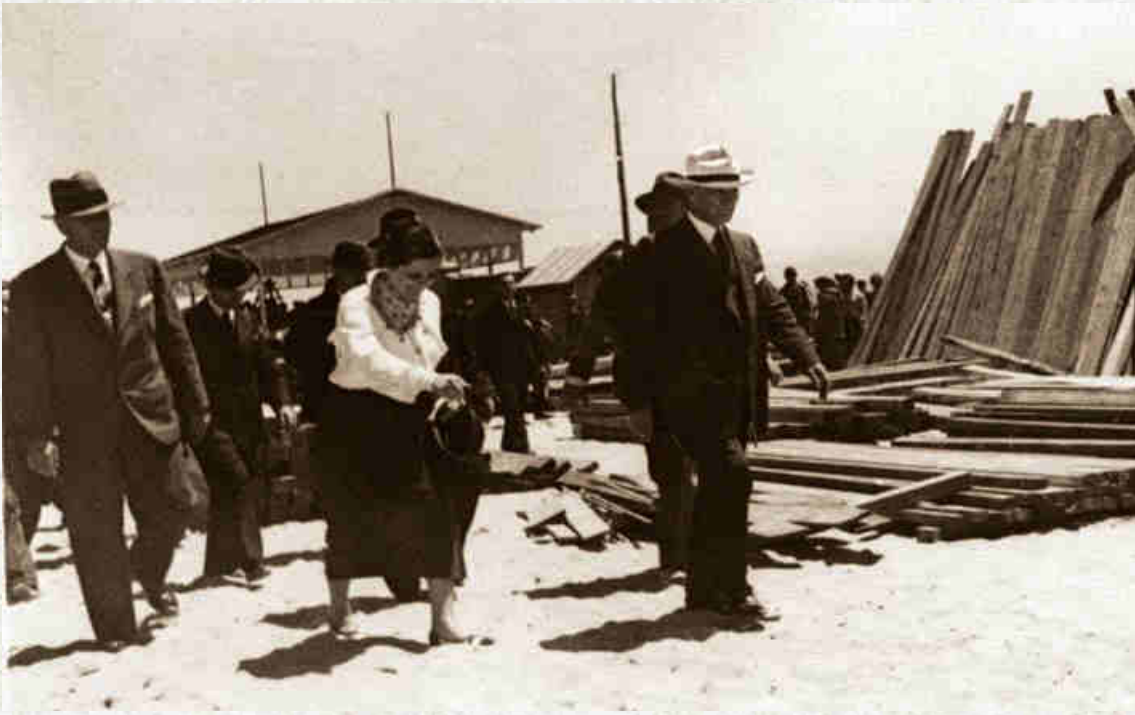
Afet İNAN ile birlikte Florya'da yapımına başlanan köşk inşaatını denetlerken, Florya, İstanbul, 28 Haziran 1935.
