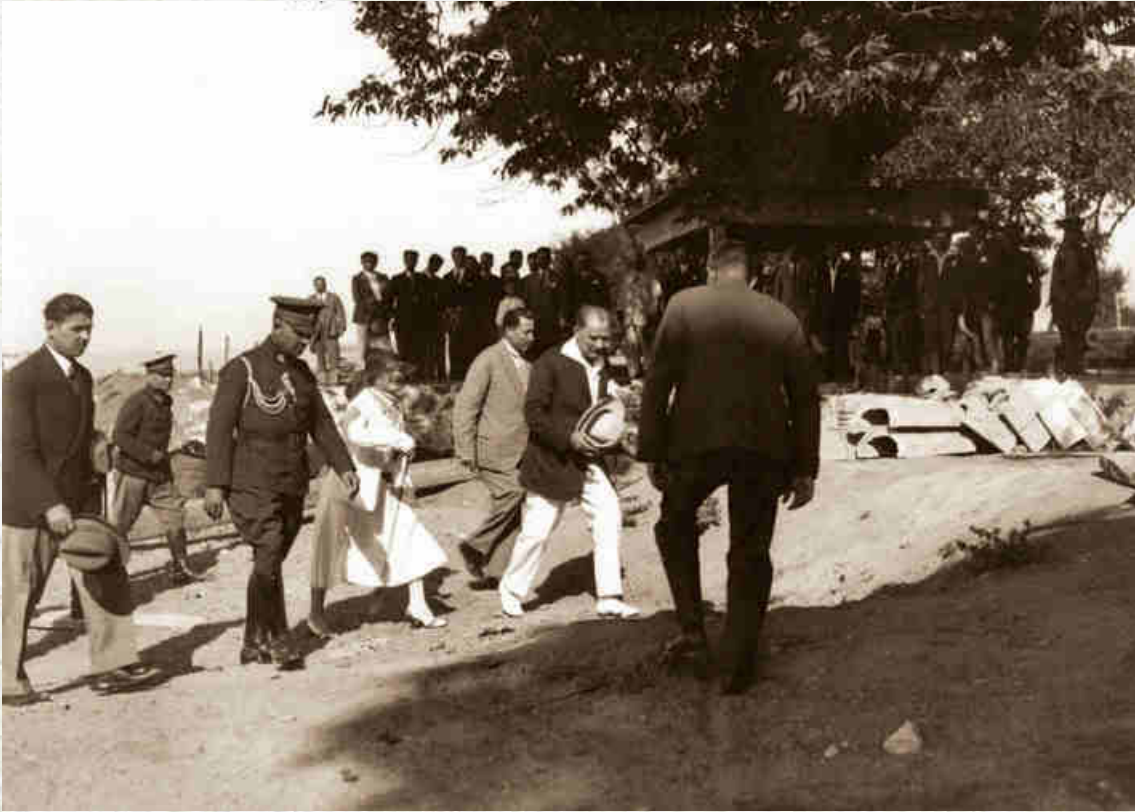
Bir ağacın kesilmemesi için raylı sistemle taşınan köşkün inşaatı, Yalova, 8 Ağustos 1930.
